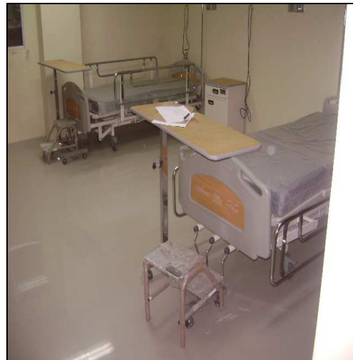
Hospital Arroz Barato Dotaciones sin usar Obras Inconclusas
