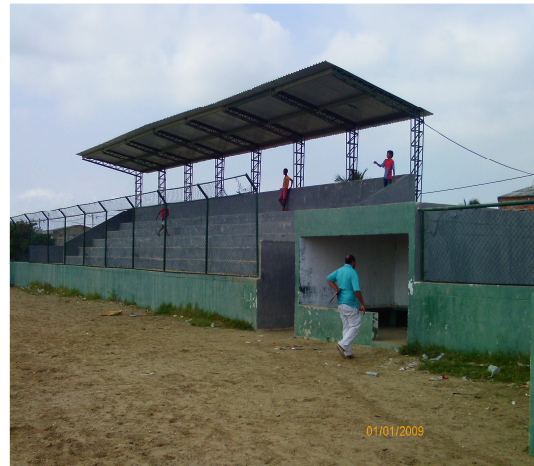
Ilustración 8 Estadio Softbol Pozón - Deterioro
