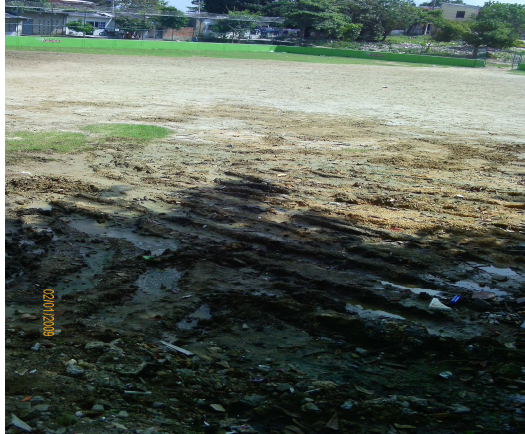
Ilustración 9 C. Softbol Chapacua - Deterioro Terreno
