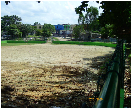
Ilustración 10 C. Softbol Chapacua - Deterioro Terreno
