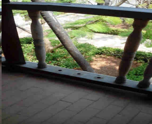
BALCON SEGUNDO PISO INSTALACIONES DADIS
