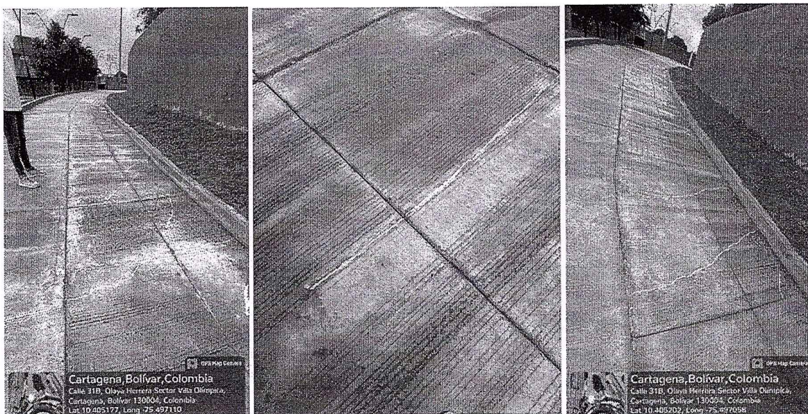
Evidencia fotográfica fisuras reparadas - visita de inspección técnica
