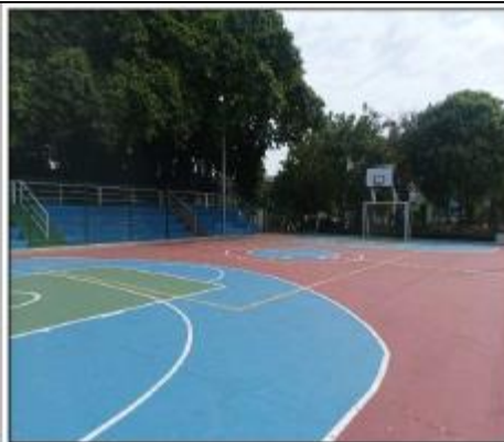
Condiciones finales placa deportiva
