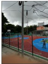
Aplicación segunda mano de pintura placa deportivo y demarcación
