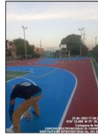
Aplicación segunda mano de pintura demarcación
