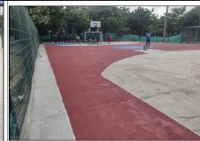
Aplicación primera mano de pintura placa deportivo y demarcación
