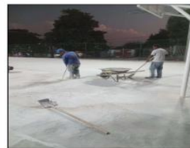
Limpeza y sellado de juntas cancha deportiva
