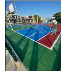
Aplicación primera mano de pintura placa deportivo y demarcación
