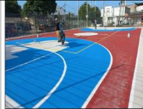
Aplicación primera mano de pintura placa deportivo y demarcación
