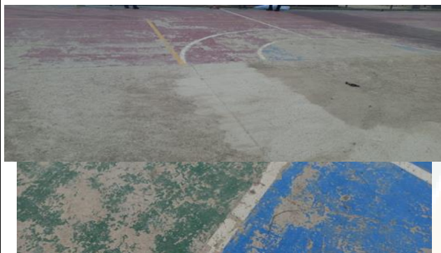
Imagen pintura cancha múltiple bocachica
