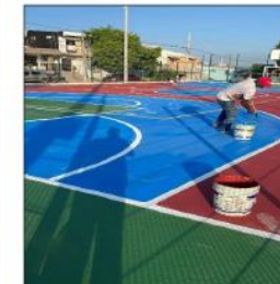
Aplicación segunda mano de pintura placa deportivo y demarcación
