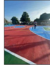
Aplicación segunda mano de pintura placa deportivo y demarcación
