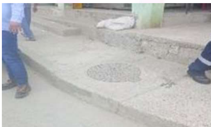
Preparación de la banca Estado actual de la placa con hundimiento
