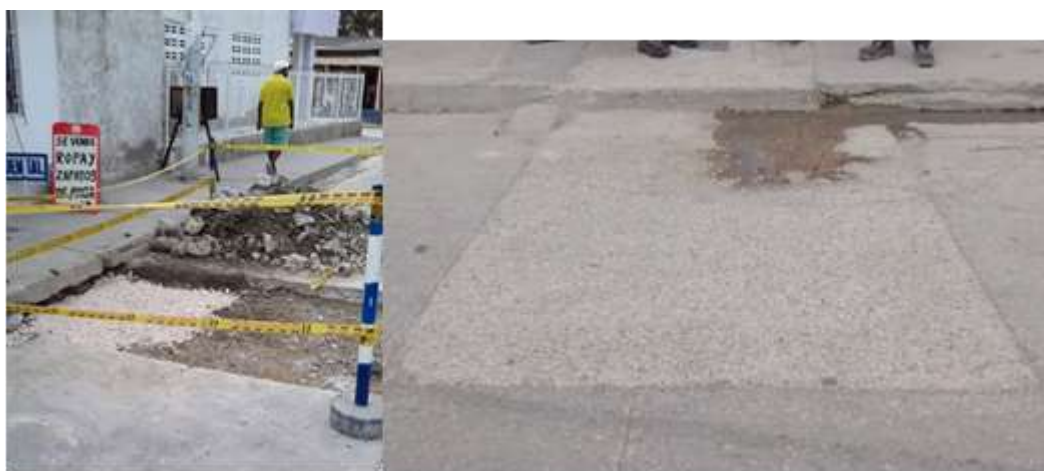
Preparación de la banca Estado actual de la placa con hundimiento
