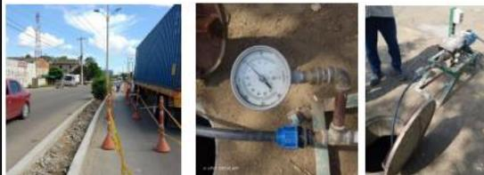
Reconstrucción de vía en pavimento asfáltico, construcción de bordillos y prueba hidrostática.
