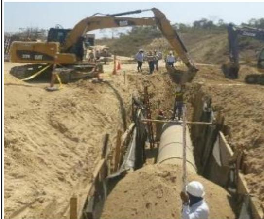
Instalación de tubería de conducciones internas de 1200mm
