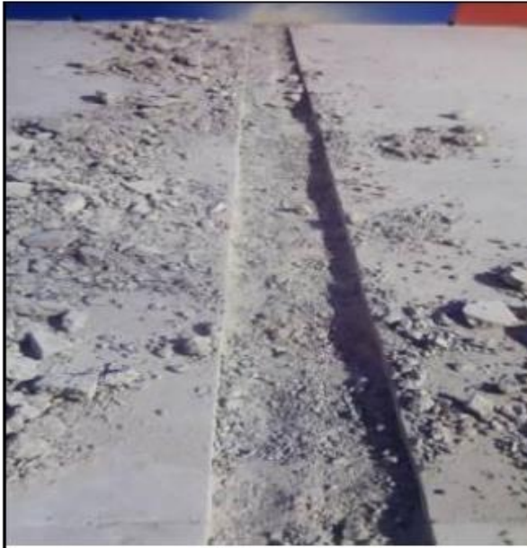
Foto No. 1 Demolición de tramo de plantilla en mal estado
