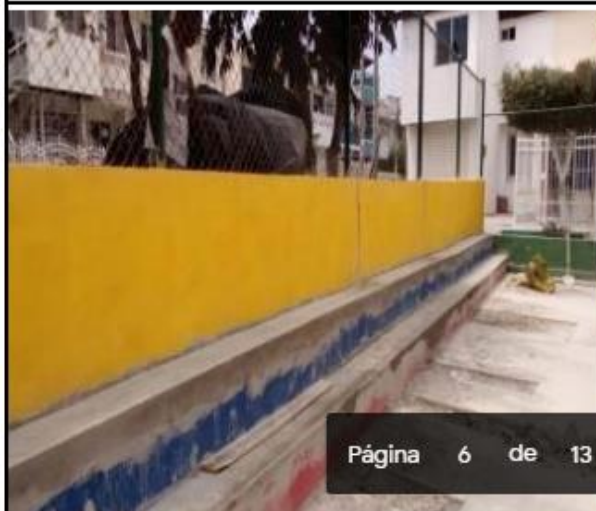
Foto No. 3 Concreto de 3000 psi para plantilla
