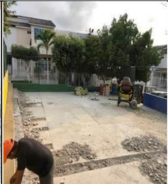
Foto No. 2 Demolición de tramo de plantilla en mal estado
