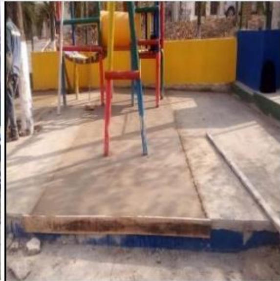
Foto No. 4 Concreto de 3000 psi para plantilla
