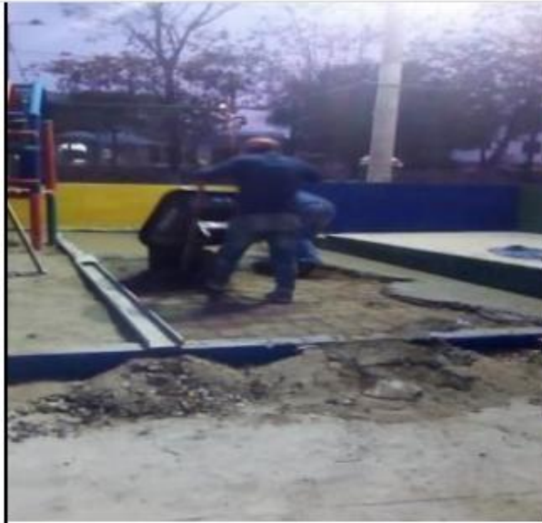
Foto No. 3 Concreto de 3000 psi para plantilla
