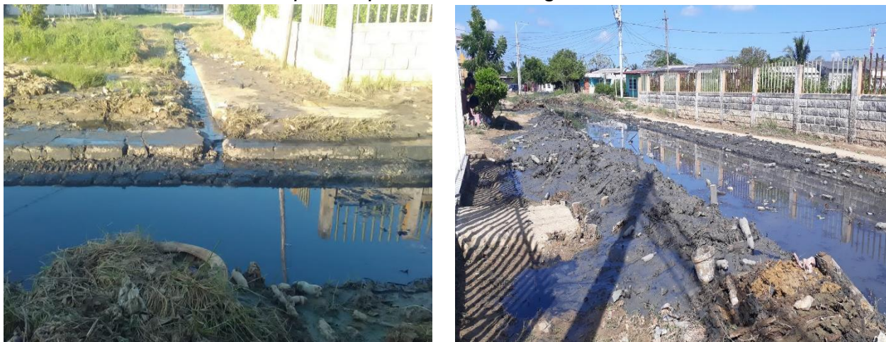
Imagen No 5. Andenes existentes y demolidos antes de la construcción del Pavimento Calle Canal 20 de Julio.
