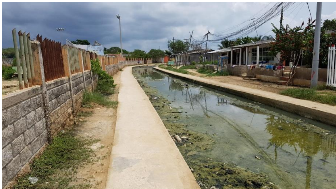
Imagen No 2. Tramo desde abscisa 0+340.00 hasta final de calle 20 de julio ampliado 83 metros
