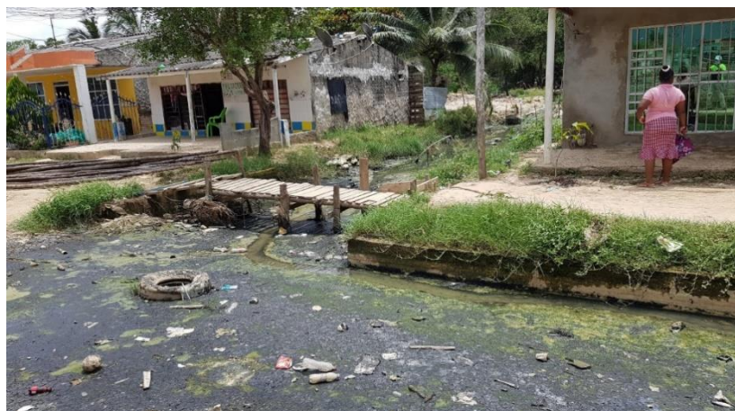
Imagen No 3. Llegada final de calle 20 de julio, nuevo punto para iniciar el canal de desagüe al cuerpo receptor
