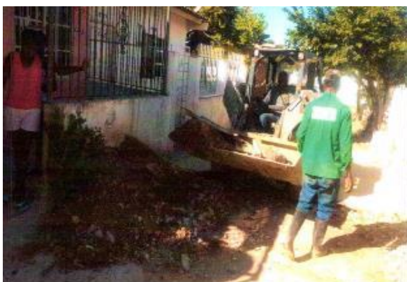
DEMOLICION Y RETIRO DE ESTRUCTURAS EXISTENTES
