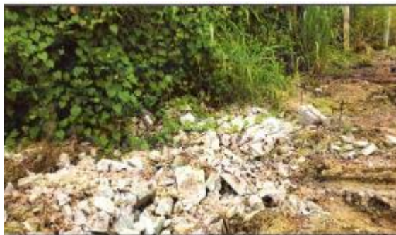
DEMOLICIÓN Y RETIRO DE ESTRUCTURAS DE CONCRETO EXISTENTES
