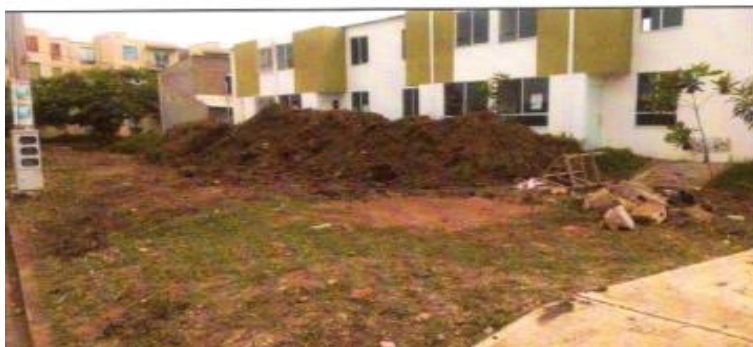
EXCAVACION Y RETIRO DE MATERIAL
