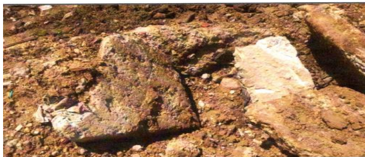
DEMOLICION Y RETIRO DE ESTRUCTURAS DE CONCRETO EXISTENTES
