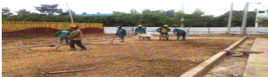
RELLENO EN MATERIAL SELECCIONADO
