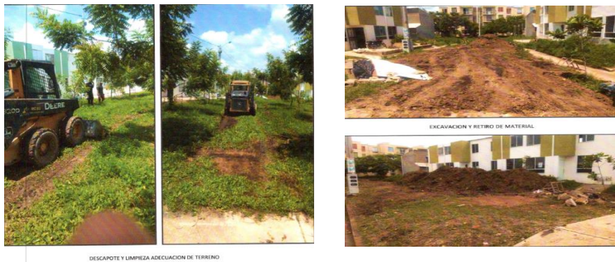
DESCAPOTE Y LIMPIEZA ADECUACION DE TERRENO
