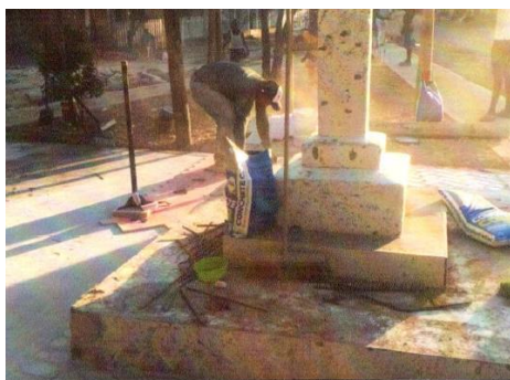
RESTAURACION DE MONUMENTO
