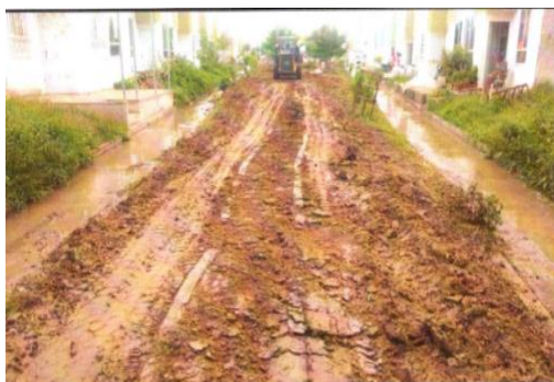
EXCAVACION Y RETIRO DE MATERIAL
