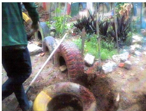
DEMOLICION DE ESTRUCTURAS EXISTENTES
