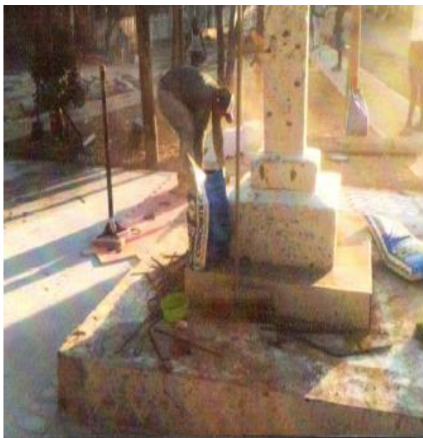
RESTAURACION DE MONUMENTO
