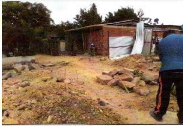
DEMOLICION Y RETIRO DE ESTRUCTURAS EXISTENTES
