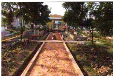
RELLENO EN MATERIAL SELECCIONADO
