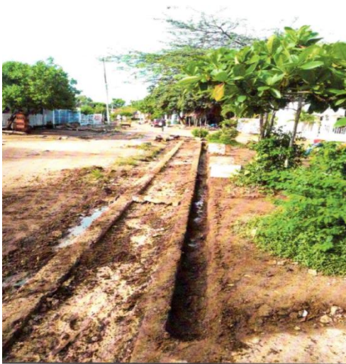
EXCAVACION DE VIGAS DE CIMENTOS 30x30
