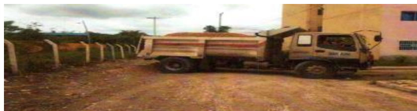
Imagen: relleno seleccionado directamente sobre terreno descapotado
