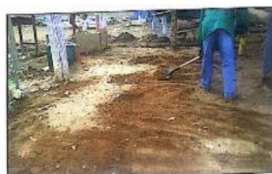
RELLENO EN MATERIAL SELECCIONADO
