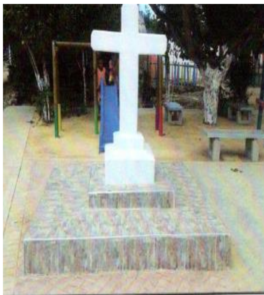
RESTAURACION DE MONUMENTO
