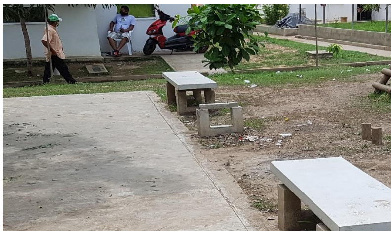
Imágenes de Bancas de los parques desniveladas. Sin acero de refuerzo, de mal material
