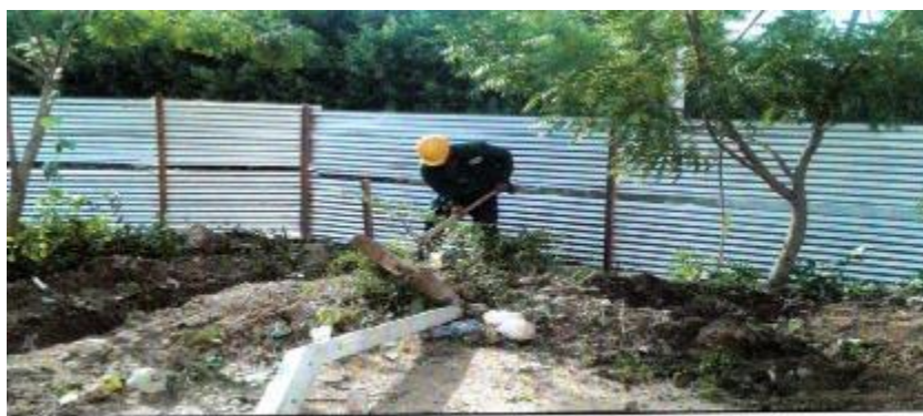
DEMOLICION ESTRUCTURA EXISTENTE
