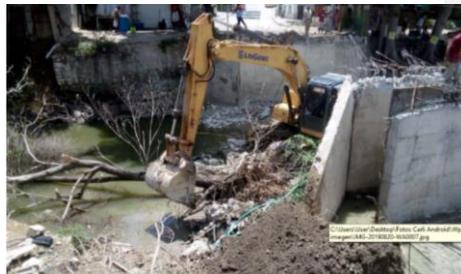
Imagen 7 – Demolición del Box Antiguo
