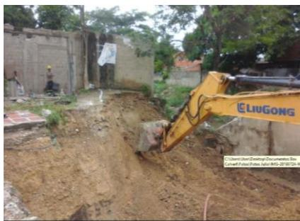
Imagen 11 - Proceso de Excavación con Retroexcavadora
