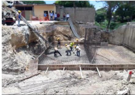
Imagen 18 – Armado del acero de los muros.
