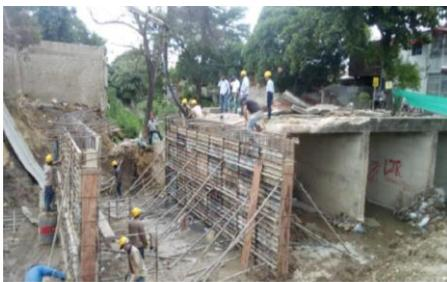
Imagen 6 – Vaciado de muros del Box
