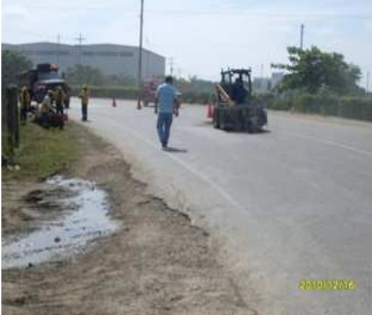
OBRAS DE MANTENIMIENTO VIAL
