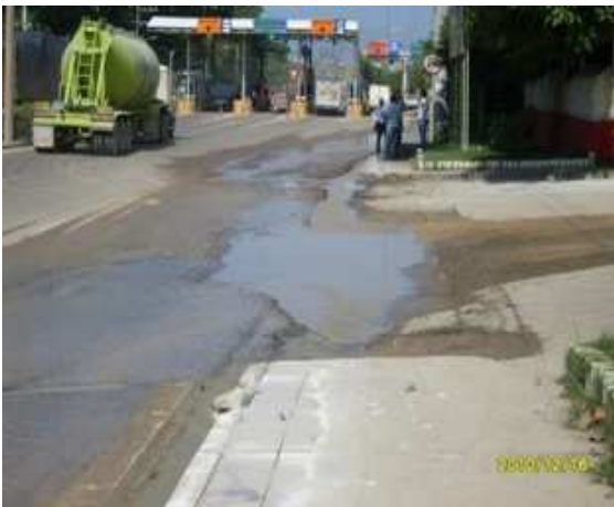
DAÑOS OCASIONADOS A LA VIA POR EVACUACION DE AGUAS DE LA EMPRESA HOLCIM.
