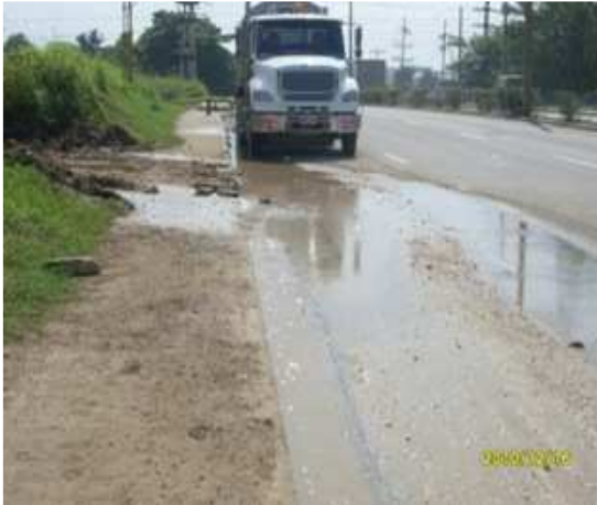
DAÑOS OCASIONADOS EN LA VIA POR EVACUACION DE AGUAS DE LA EMPRESA HOLCIM.
