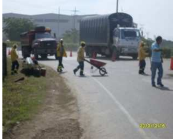
OBRAS DE MANTENIMIENTO VIAL
