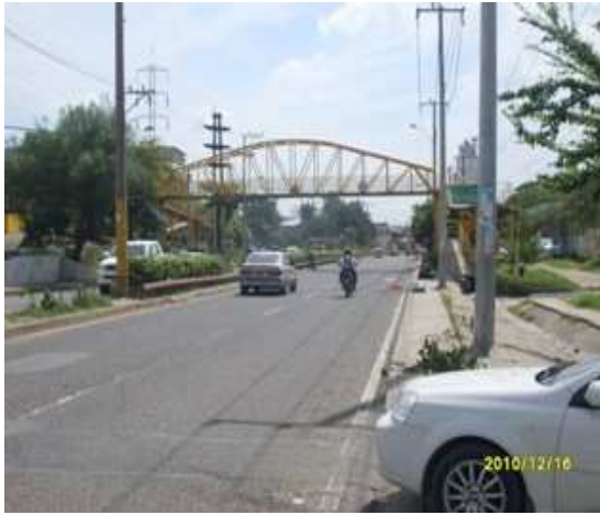
PUENTE PEATONAL INST. EDUCATIVA OLGA GONZALEZ DE ARRAUT + VISTA DEL PAVIMENTO AVE. CRISANTO LUQUE
