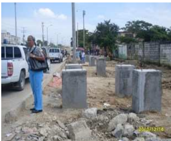
OBRAS DEL OTROSI No.9: COLUMNAS PARA SOPORTE DEL PUENTE PEATONAL SECTOR CLINICA ENRIQUE DE LA VEGA.
