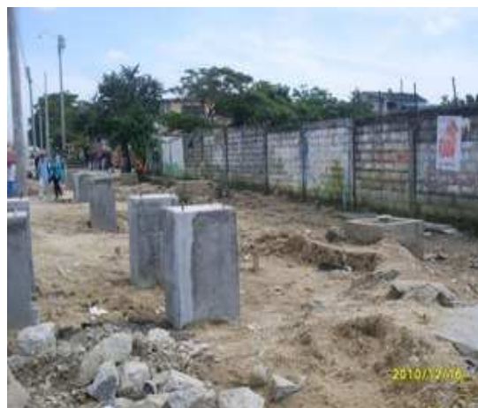
OBRAS DEL OTROSI No.9: COLUMNAS PARA SOPORTE DEL PUENTE PEATONAL SECTOR CLINICA ENRIQUE DE LA VEGA.
