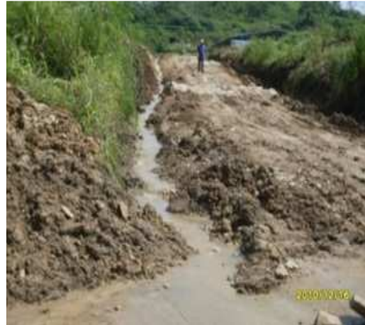
DAÑOS OCASIONADOS EN LA VIA POR EVACUACION DE AGUAS DE LA EMPRESA HOLCIM.
